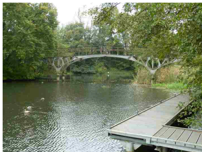
Der Anleger am Finowkanalpark in Eberswalde
