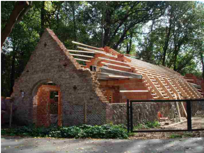
Der Stand der Baumaßnahmen am 26. September 2007
