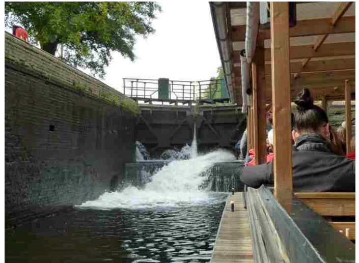
Schleusendurchfahrt Schleuse Grafenbrück
