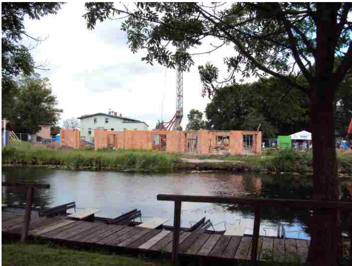
Stand der Baumaßnahmen am Stadthafen Liebenwalde am 14. Juni 2013
