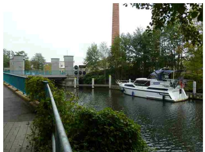
Motoryacht wartet an der Hubbrücke Eisenspalterei
