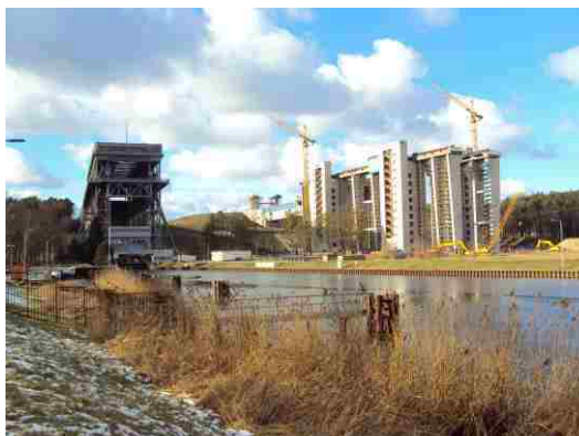
Blick auf das neue und das alte Schiffshebewerk in Niederfinow am 10. Februar 2015
