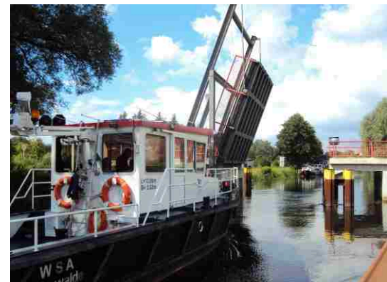
Die Klappbrücke in Niederfinow
