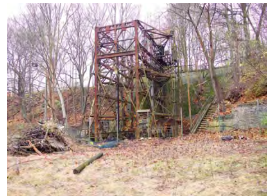
Industriedenkmal Waggonaufzug in Eberswalde
