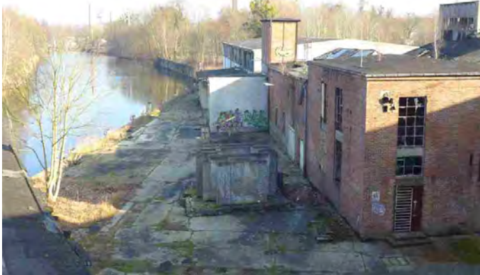
Das Gelände der künftigen Bootsfabrik Wolfsmarina liegt direkt am Finowkanal
